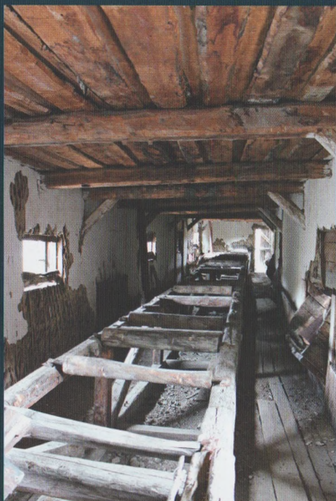
Остатки шахтного оборудования.
